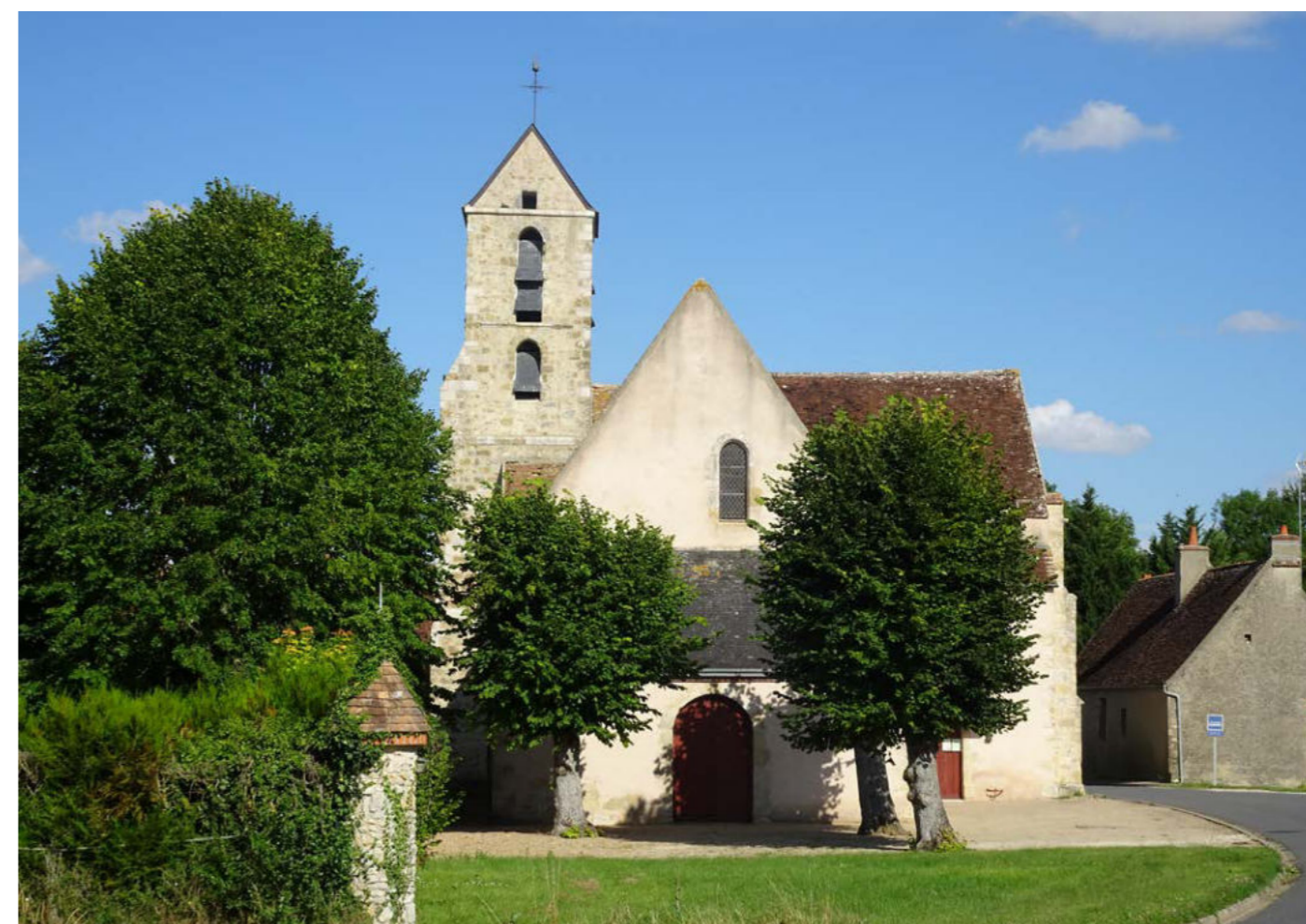
PHOTO 90 : ÉDIFICE PROTÉGÉ (© AGENCE COUASNON)
