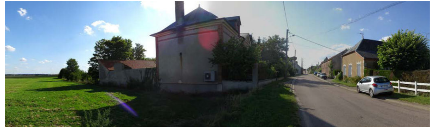
PHOTO 65 : VUE FERMÉE PAR LA TRAME BÂTIE EN DIRECTION DE LA ZIP EN ENTRÉE DE BOURG DE GONDREVILLE (© AGENCE COUASNON)
