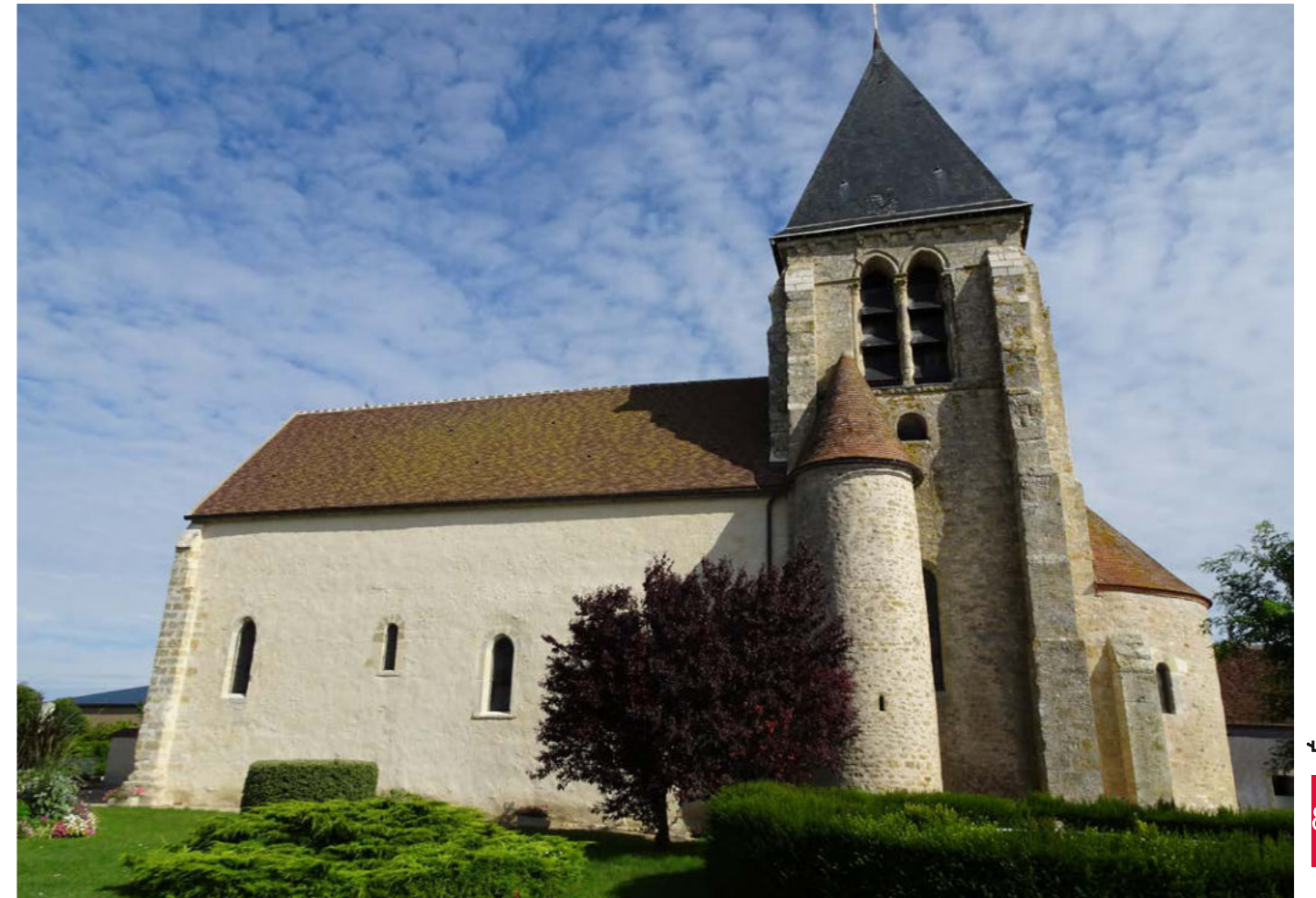
PHOTO 92 : ÉDIFICE PROTÉGÉ (© AGENCE COUASNON)
