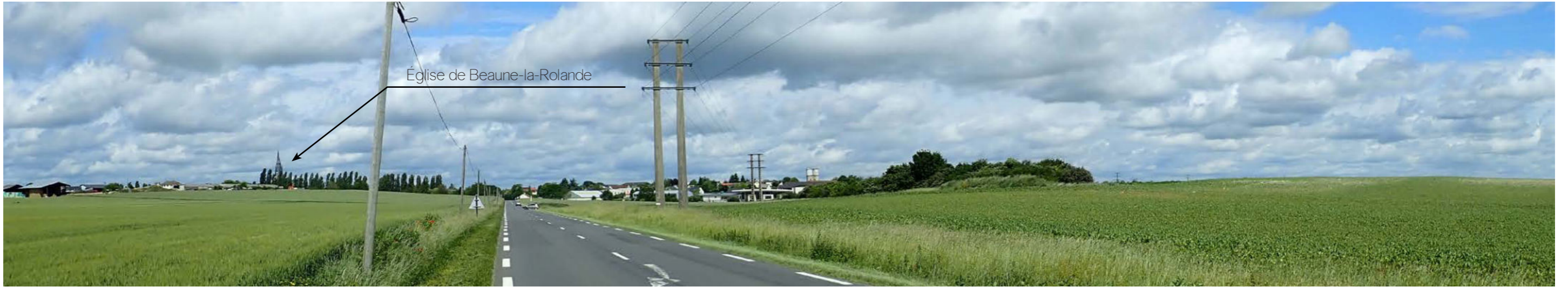
PHOTO 56 : LE TRACÉ DE LA RD 950 EST STRICTEMENT RECTILIGNE AU SEIN DE L'AIRE RAPPROCHÉE SUR PLUSIEURS KILOMÈTRES, DE PLUS, LE SITE D'IMPLANTATION POTENTIEL PREND PLACE DANS L'AXE DE CETTE ROUTE ET LES VUES SONT MAJORITAIREMENT OUVERTES BIEN QU'AU FUR ET À MESURE QUE L'ON S'APPROCHE DE L'AIRE IMMÉDIATE, LA TRAME VÉGÉTALE ET BÂTIE DE BEAUNE-LA-ROLANDE TRONQUE LES VUES EN DIRECTION DE LA ZIP (© AGENCE COUASNON)
