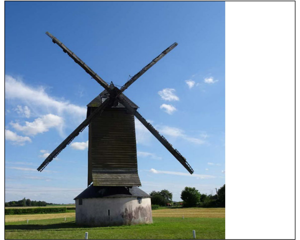
PHOTO 27 : ÉDIFICE PROTÉGÉ (© AGENCE COUASNON)
