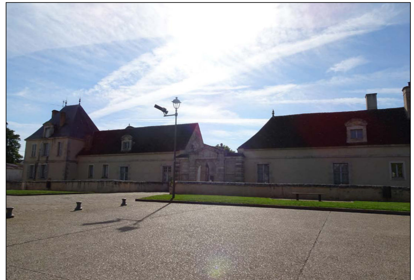
PHOTO 88 : ÉDIFICE PROTÉGÉ (© AGENCE COUASNON)
