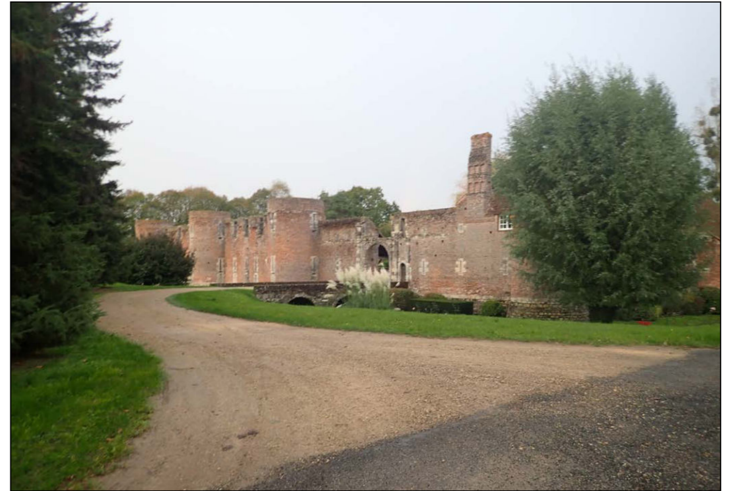
PHOTO 23 : ÉDIFICE PROTÉGÉ (© AGENCE COUASNON)
