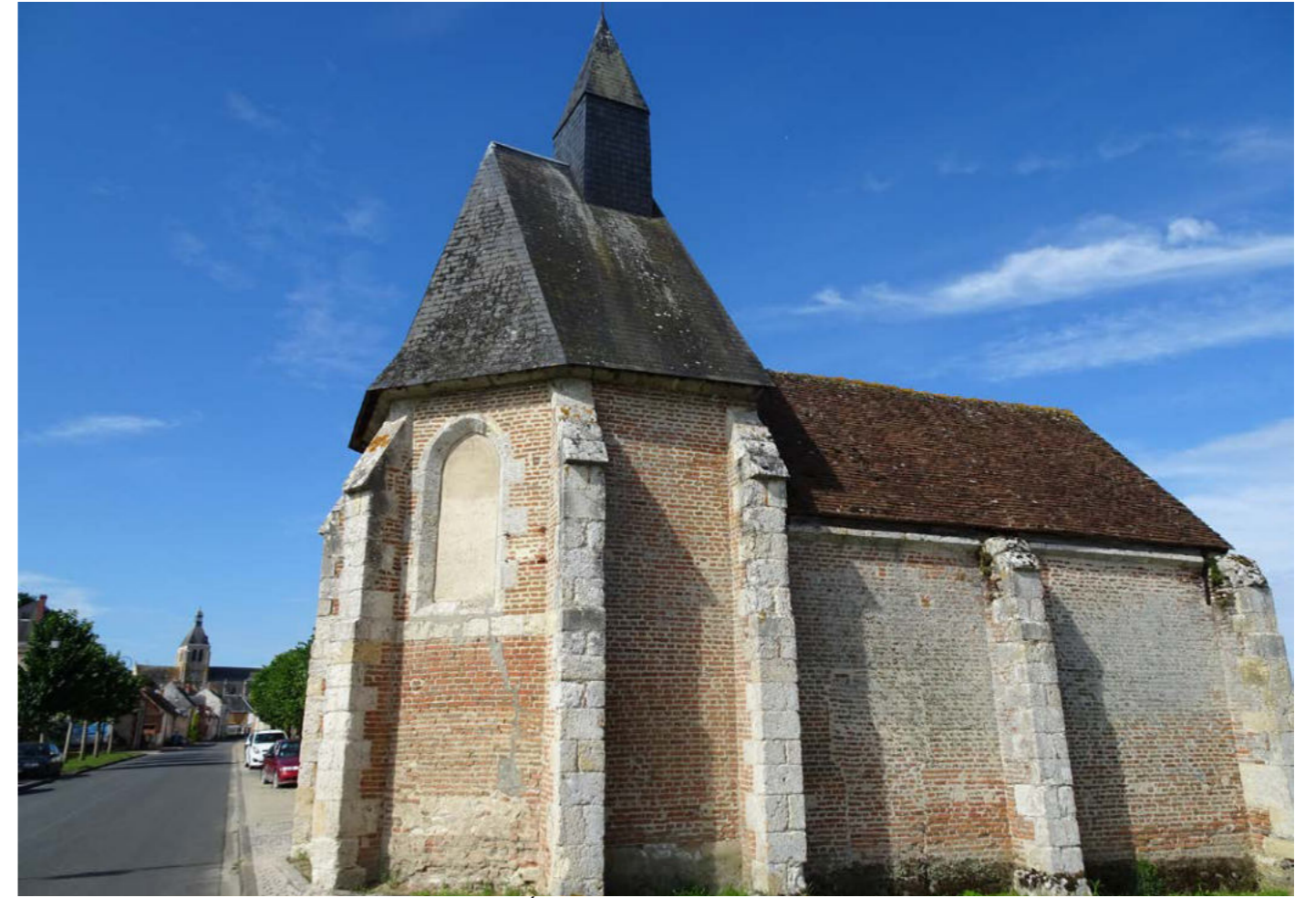
PHOTO 94 : ÉDIFICE PROTÉGÉ (© AGENCE COUASNON)
