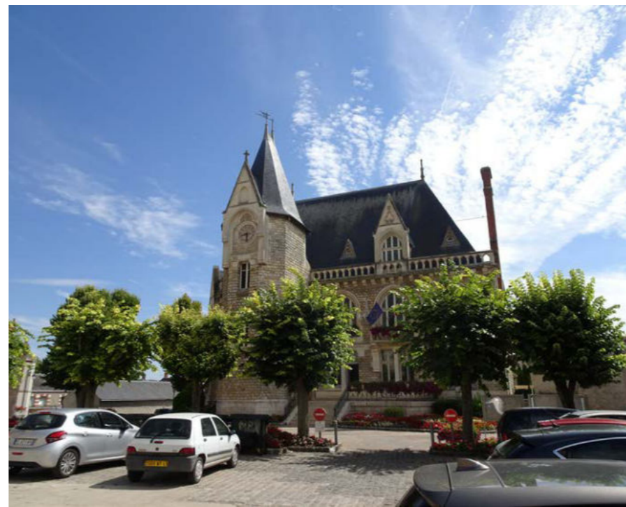
PHOTO 39 : MAIRIE DE LA VILLE DE PUISEUX (© AGENCE COUASNON)
